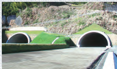
第二東名清水第四トンネル【静岡県】
