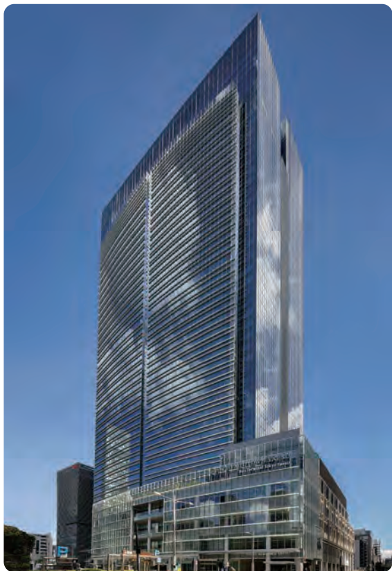
施工面積：352,000㎡ 施工年：2022年
