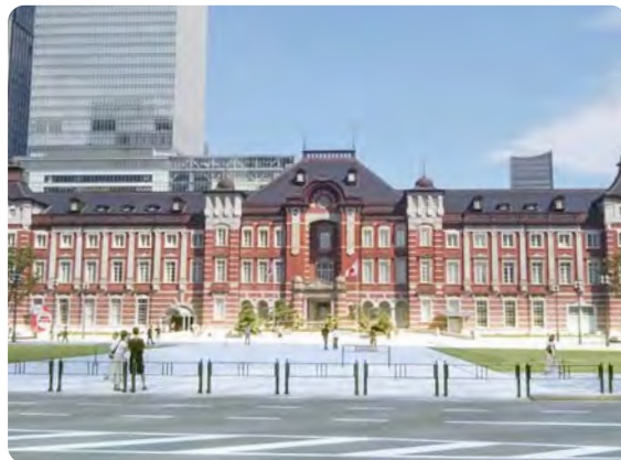
施工面積：6,000㎡ 施工年：2012年
